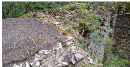
Po odborném ošetření a stabilizaci koruny zdiví zdi je na první pohled vidět rozdíly, 2019
